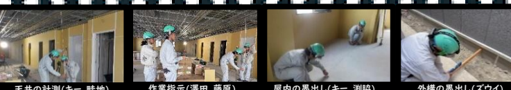
天井の計測(キー、畦地)
