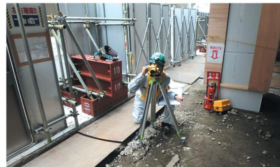
レベル測量を行い、高さの基準を決め、基準墨を出します。オートレベル(測量機器)を覗いている様子です。
