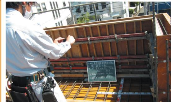
施工中の状況を工事写真として記録をします。この写真は、鉄筋の配筋状況を撮影しています。
