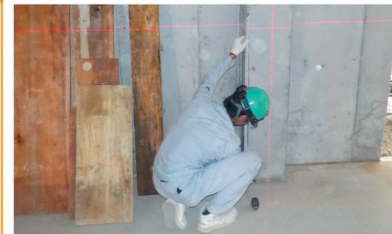
高さの基準線から、床の高さになる位置を測っています。建物内部の墨出しでは、レーザーという機器を使用しています。
